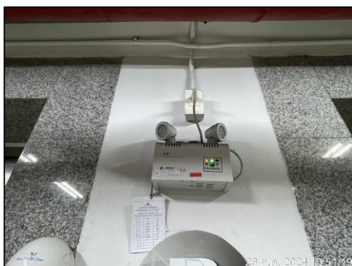
ภาพที่ 22 ไฟฟ้าฉุกเฉิน
