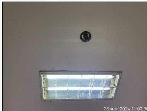
ภาพที่ 25 หัวกระจายน้ำดับเพลิง
